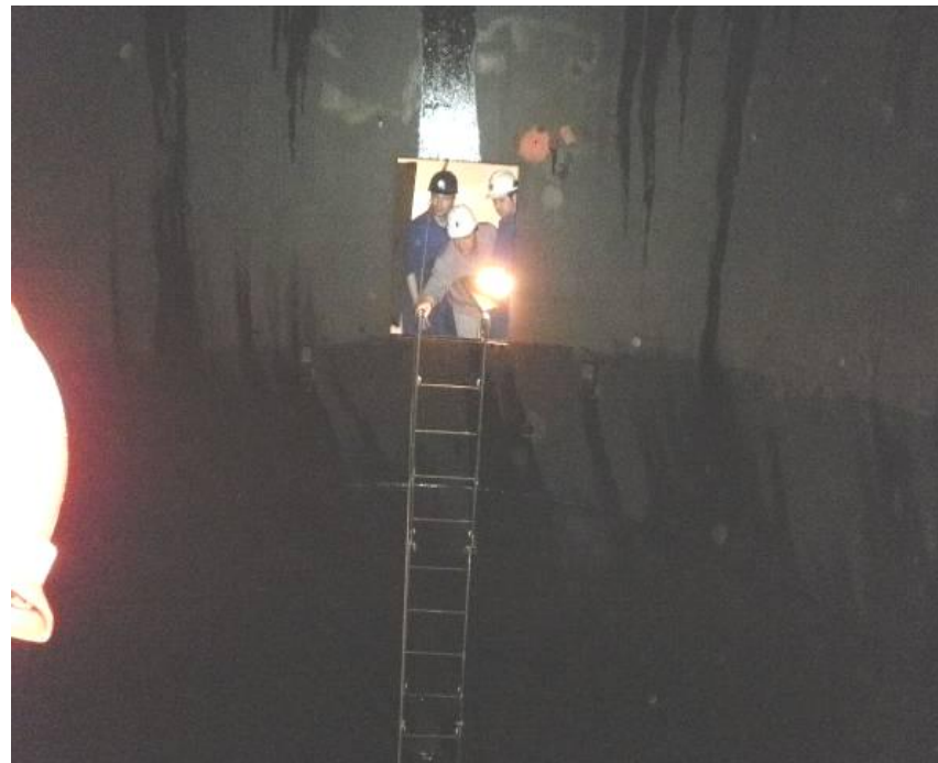
Instalação de escada para descida ao interior do poço.
