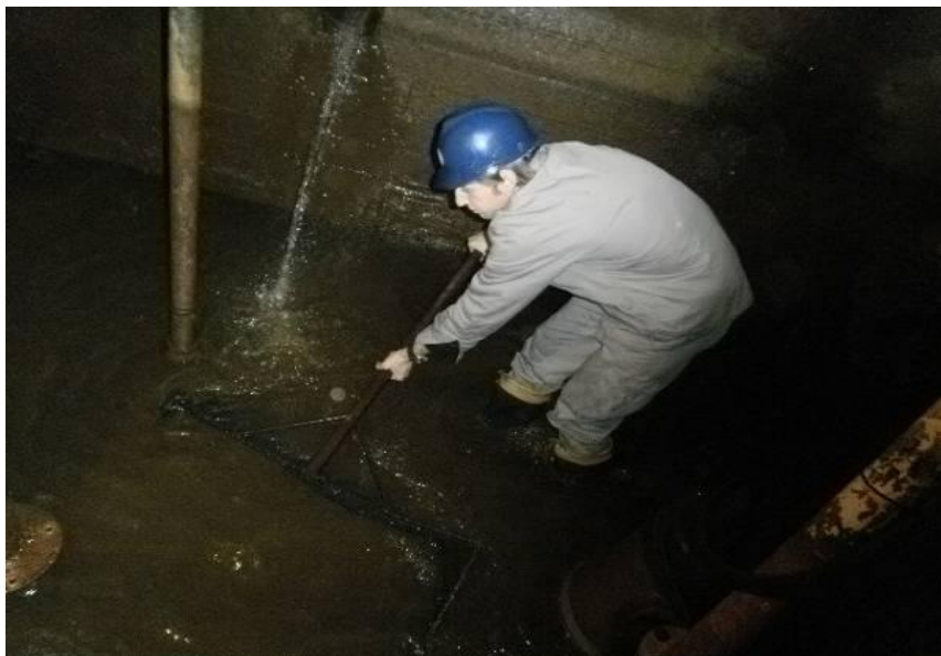
Resgate no interior do poço
