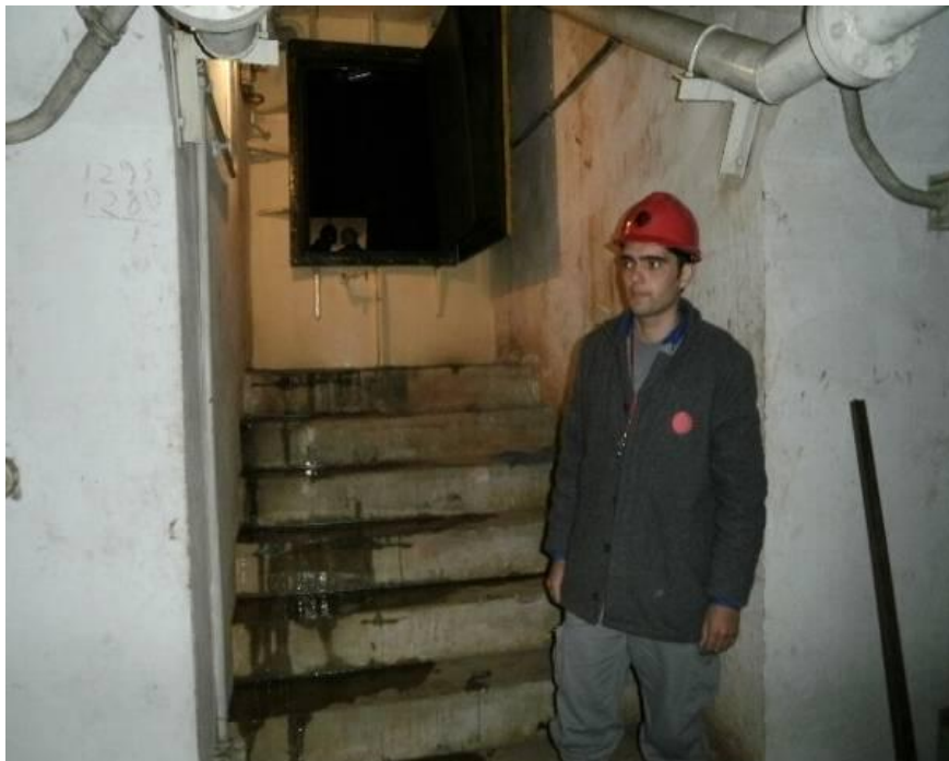
Local de acesso ao poço difusor
